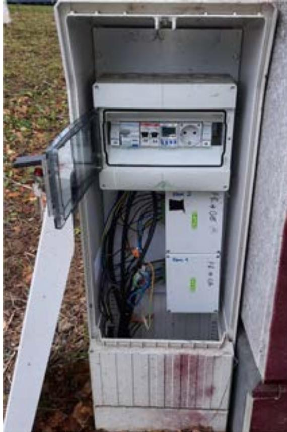
Abbildung 56: Gatso-Messanlage - Schnittstellen.<sup>113</sup>
